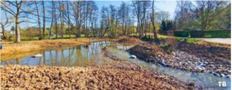
Im Rahmen des Landesprogrammes „Gewässerentwicklung und Hochwasserschutz“ wurde im Winter 2019/2020 in Elz ein 400 m langes Teilstück des Erbaches bis zur Mündung in den Elbbach renaturiert. Über eine sehr lange Zeit war der Bach begradigt und die Sohle mit Betonsteinen befestigt. Es entstand wieder ein natürlicher Bachlauf mit verschiedenen Breiten, Tiefen und Uferzonen, die für einen biodiversen Lebensraum sorgen.
